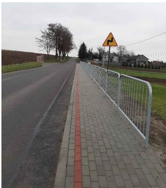
Chodnik z poszerzeniem jezdni
