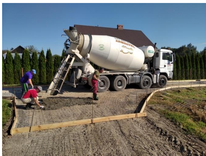
Droga betonowa w trakcie realizacji
