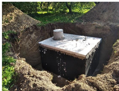
Zbiornik bezodpływowy na ścieki komunalne na potrzeby Oficyny Dworskiej
