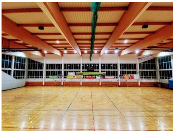
Modernizacja oświetlenia hali sportowej
