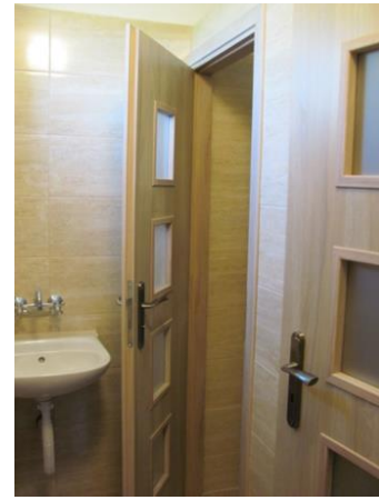
Przebudowane sanitariaty w remizie OSP
