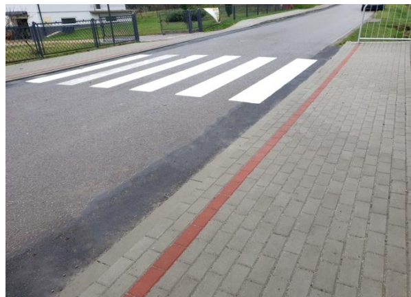
Chodnik przy drodze powiatowej w Siennowie
