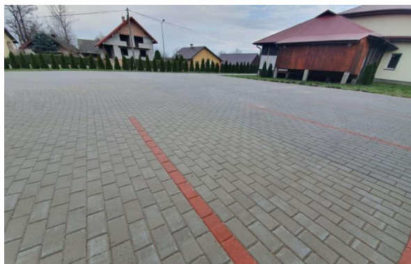
Budowa parkingu i dróg wewnętrznych przy OSP
