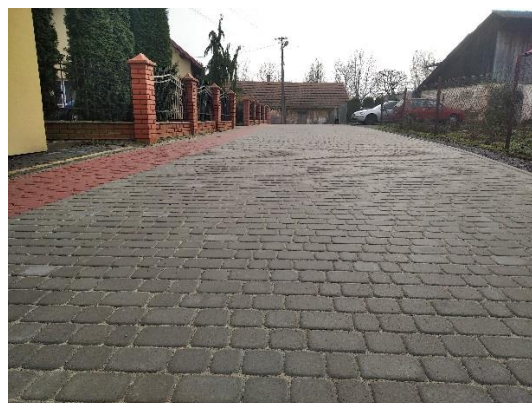
Droga z kostki brukowej w Zarzeczcu
