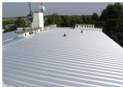
Przebudowany dach na Ośrodku Zdrowia
