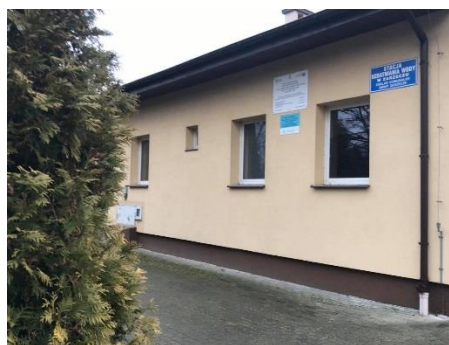
Stacja Uzdatniania Wody w Zarzeczu przed rozpoczęciem robót
