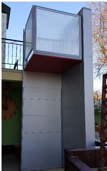
Platforma windowa przy ŚDS
