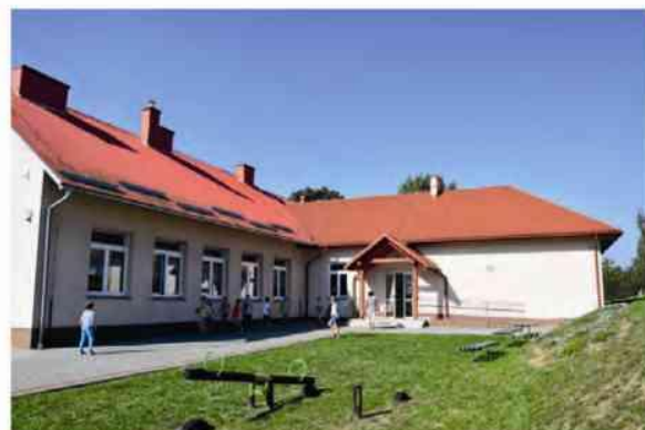
Sala gimnastyczna przy szkole w Maćkówce
