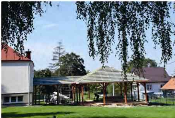
Budowa wiaty przy OSP w Maćkówce
