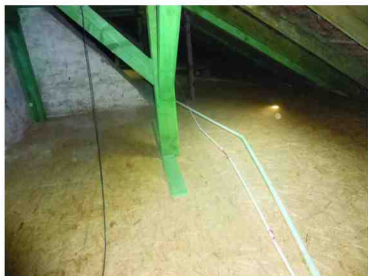
Wymienione elementy konstrukcji pałacowego dachu
