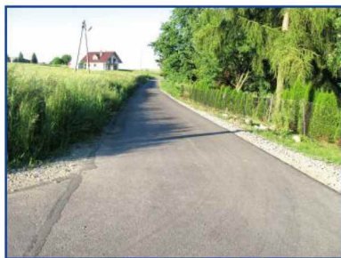
Nowa nawierzchnia drogi w Zalesiu
