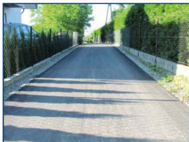
Nowa droga w Zarzeczcu
