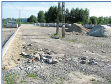
Budowa parkingu w Żurawiczkach
