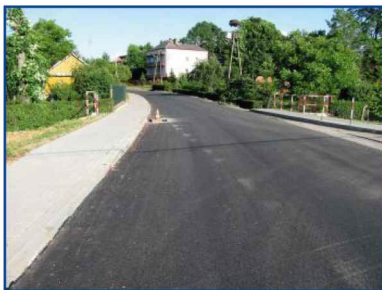
Remont drogi powiatowej Zarzecki - Żurawiczki
