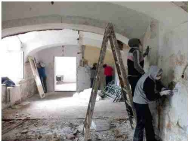
Członkowie Spółdzielni w trakcie remontu siedziby
