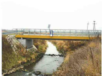
Zdjęcie urządzenia zamontowanego na Mleczce
