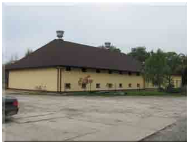
Zmodernizowana oczyszczalnia ścieków
