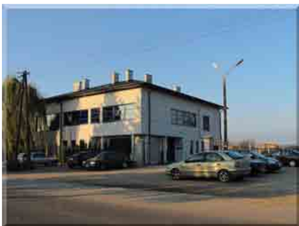
Nowy budynek administracyjny GPR w Zarzeczcu
