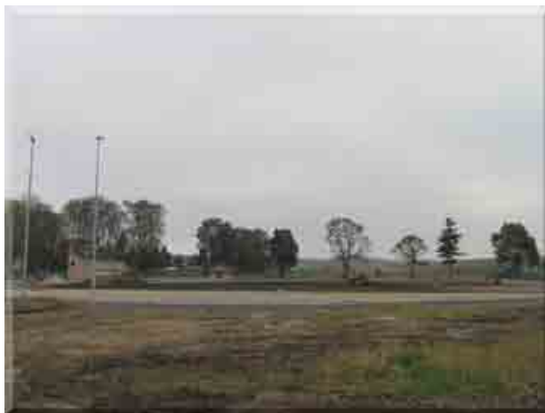
Budowa Gminnego Centrum Sportu i Rekreacji
