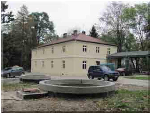
Odnowiona elewacja oficyny w Zarzecz
