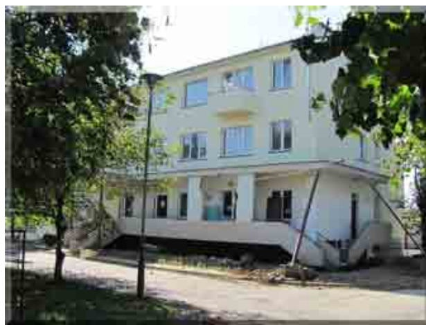
Ośrodek Zdrowia w Zarzeczcu w trakcie remontu
