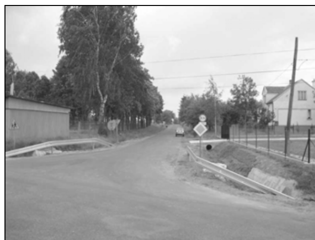
Nowa nawierzchnia drogi w Roźniatowie - Parcelacja
