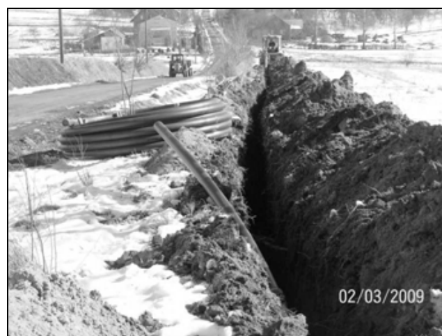
Wymiana sieci wodociągowej w Zalesiu
