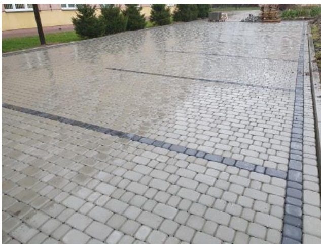
Budowa drogi wewnętrznej i parkingu przy internacie
